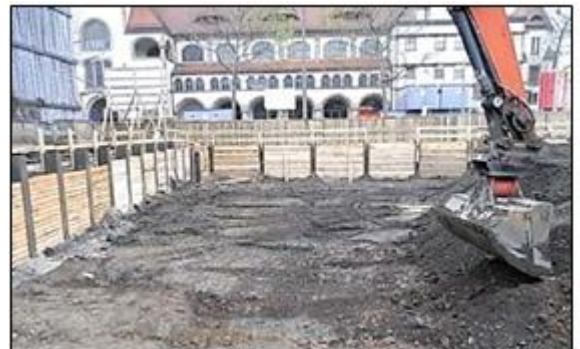
Abbildung 4 Schichtenweiser Abtrag, verpflichtend bei baubegleitender KMR
